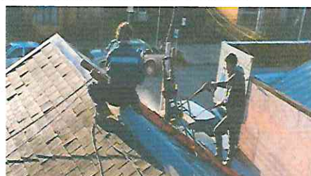
Reparaciones filtraciones CESFAM T. Schmidt
