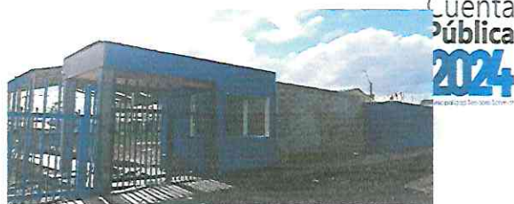
Mejoramiento Acceso y Cierre Perimetral Estadio Barros Arana
