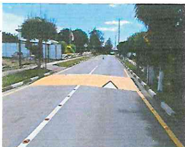
Instalación de resaltos, Calle Dos Sur, Barros Arana.
