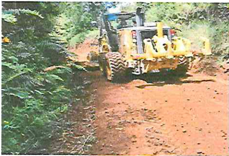
Habilitación de caminos Vecinales.
