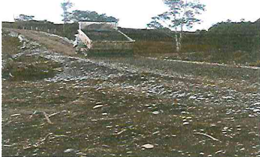
Perfilado y mantención de Caminos Vecinales.
