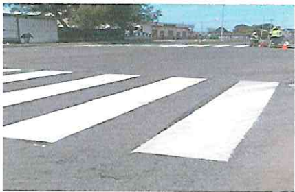
Demarcación de pintura paso de cebra, localidad de Hualpin.
