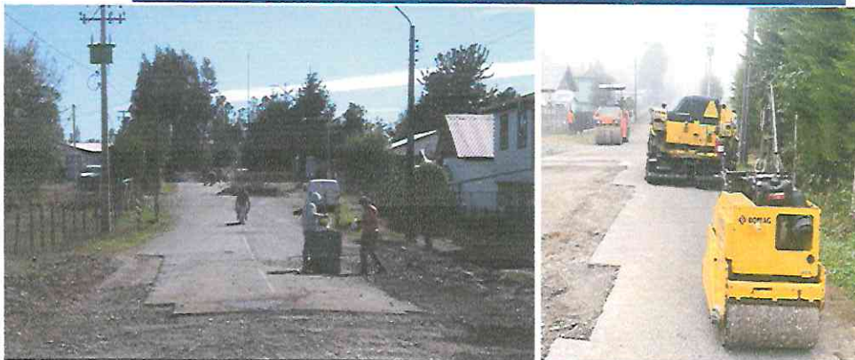
REPARACIÓN ASFALTICA TRAMO 200 MTS CALLE 4 PONIENTE LOCALIDAD DE BARROS ARANA MONTO=$10.590.000
